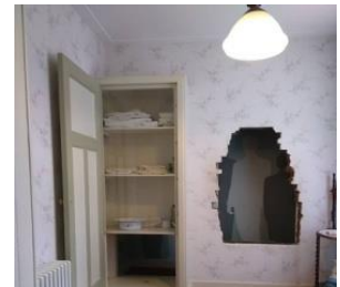
屋根裏に続くロッカーの最下段
